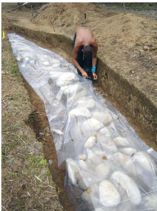
Fig. 43 Cubrimiento de estructuras con plástico perforado
